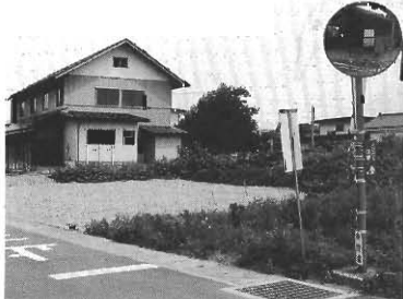
舗装は14年度予定。盛土工事は山崎工業さんで無償でしていただきました。
