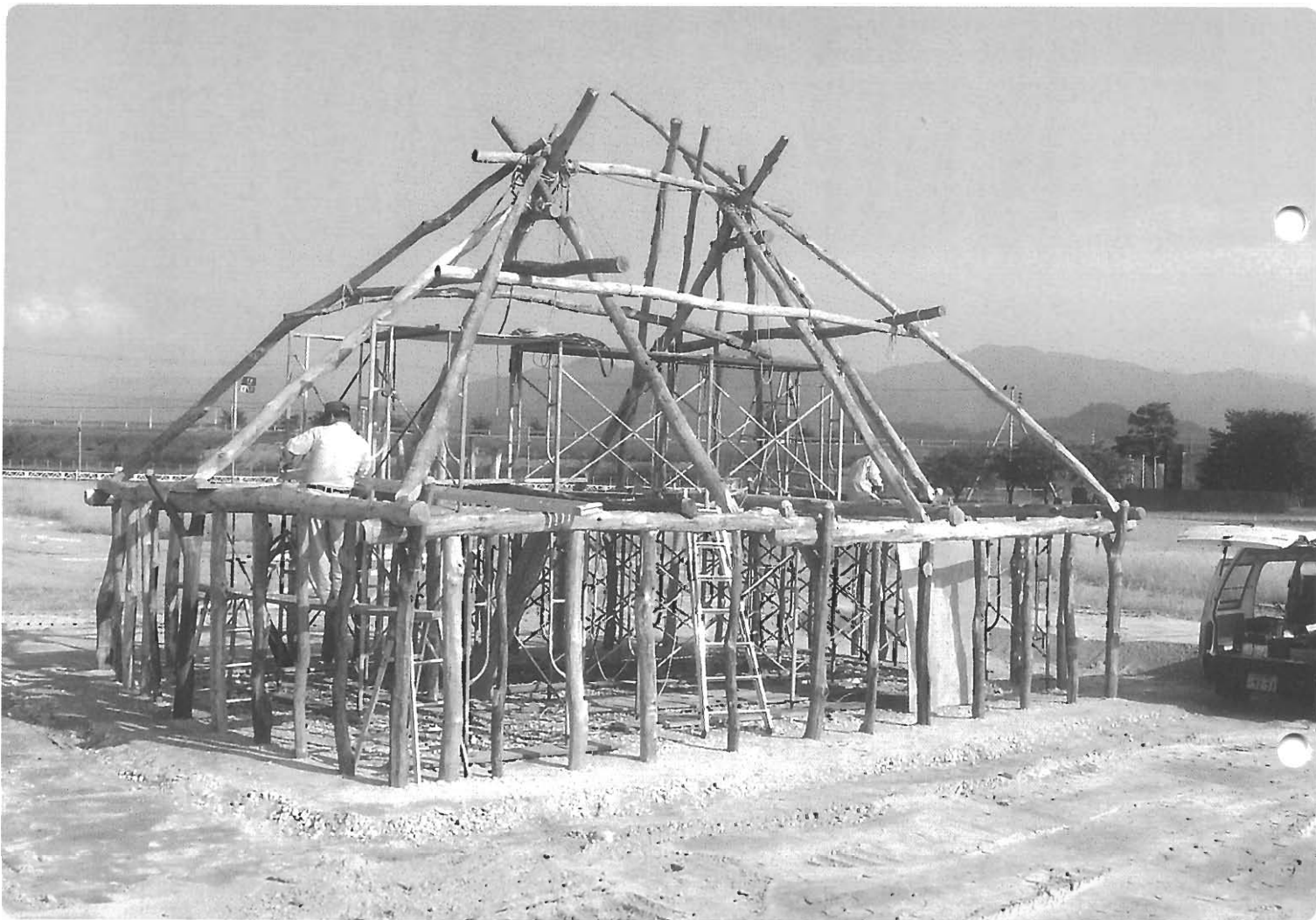
遺跡発掘で確認された栗材を用い、建築が進む住居跡 平成17年10月27日撮影
