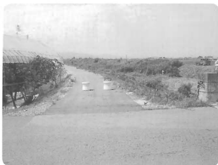
荒れた堤防がきれいに舗装されました。
